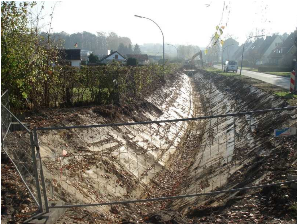
Abbildung 3: Profilierter Graben in der Straße "Am Schrebergarten" gegen die Fließrichtung
