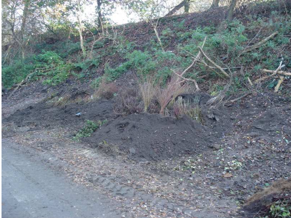
Abbildung 1: Beginn der Pflanzarbeiten im Bahneinschnitt
