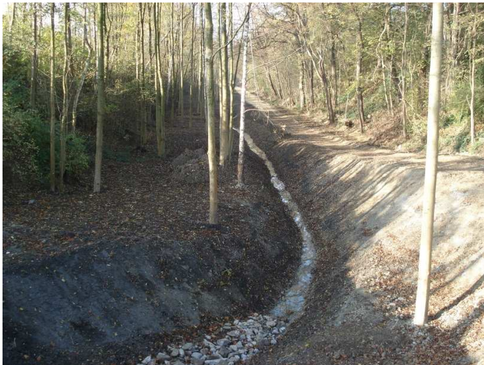
Abbildung 2: Blick in den Bahneinschnitt vor der Bepflanzung
